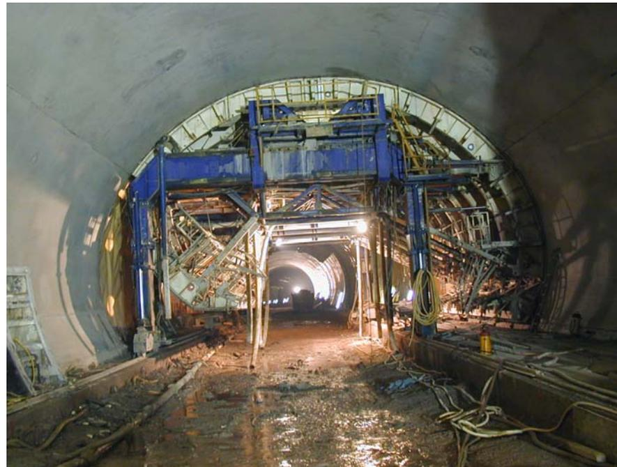
Schalwagen für den Einbau der Innenschale
