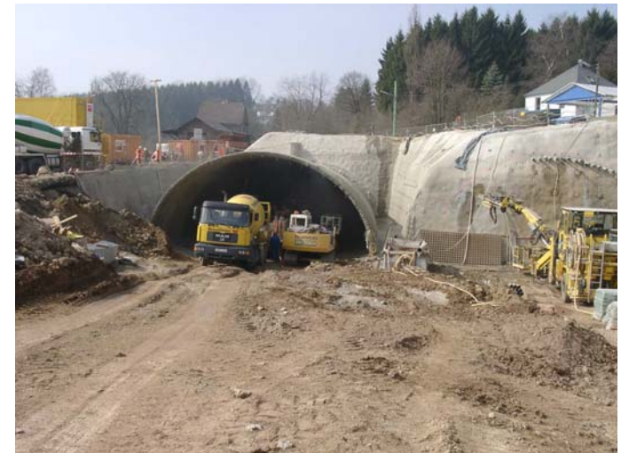
Ansicht Portal – Bergmännische Bauweise
