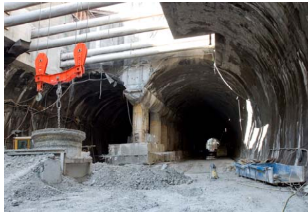
Abteufen des Südschachtes
