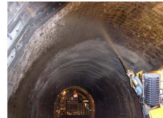
Ausbau der Hilfsbögen, Einbau der bewehrten Spritzbetonschale
