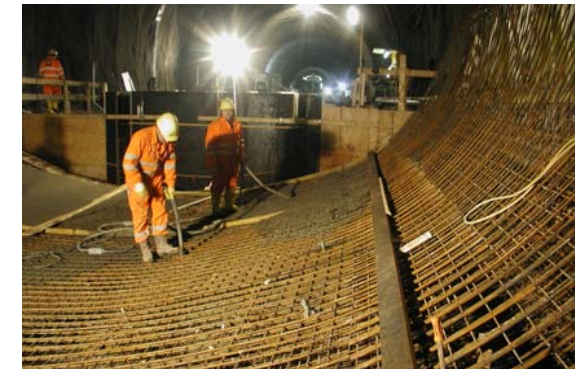
Innenschale Sohlgewölbe Oströhre
