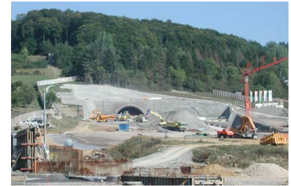
Voreinschnitt Nord (vor Anschlag der Weströhre)
