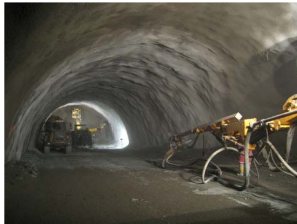
Kalottenvortrieb nach NATM
