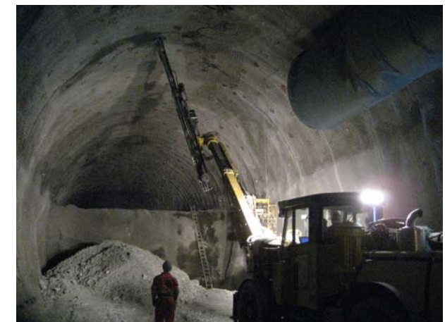
Nachlaufender Strossenvortrieb
