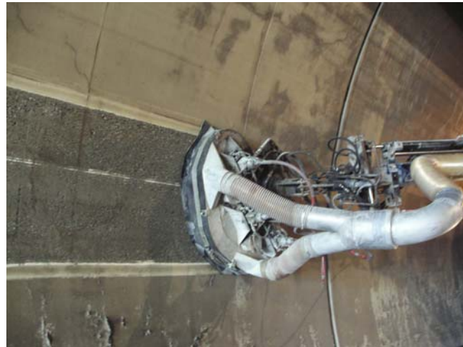
Abtrag der Altbeschichtung durch Hochdruckwasserstrahlen
