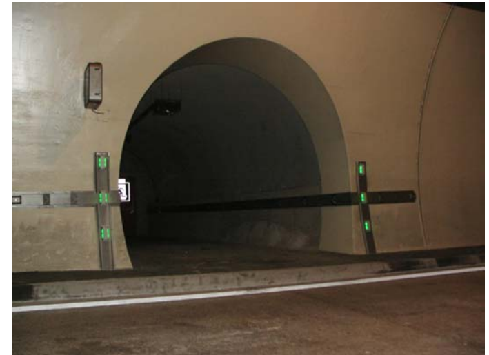
Abbruch der Ortbetoninnenschale – Herstellung Querschlag
