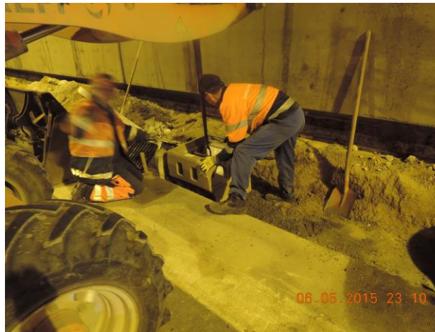
Setzen der Tauchwandschächte
