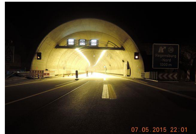
Ansicht Südportal Oströhre bei Nacht
