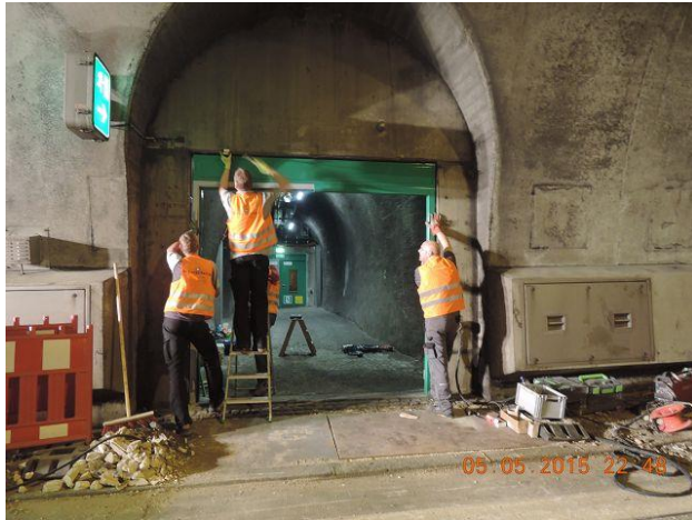
Austausch Fluchttür Querschlag Nord
