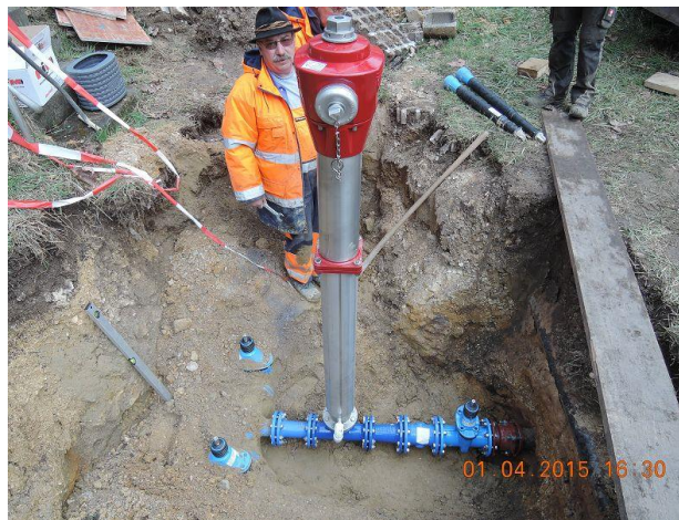
Erneuerung des Hydranten und Einbau von Schiebern zwischen den Röhren am Nordportal
