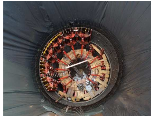
Betonierung Rettungsschacht
