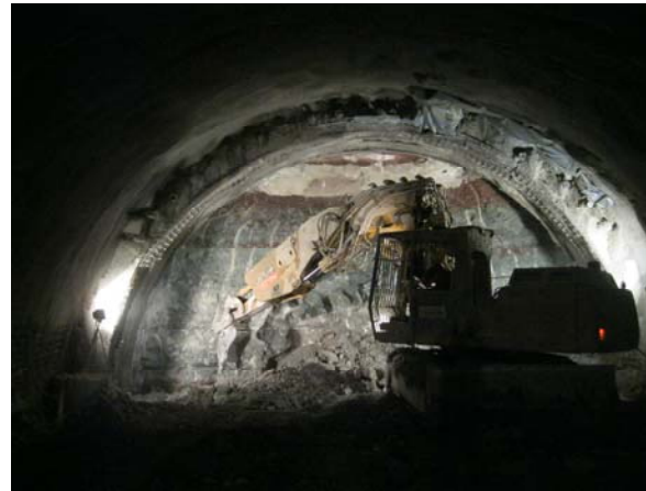
Baggervortrieb unter Rohrschirm im Bereich Querung DB Trasse und Rems
