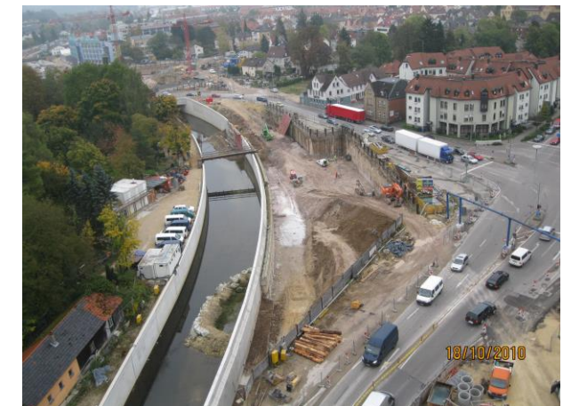
Offene Bauweise Ost und Remstrog
