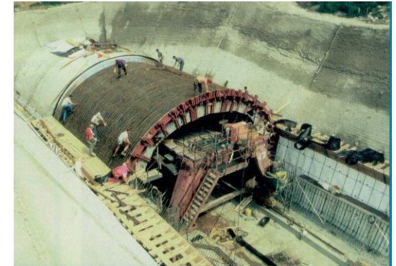
Riedbergtunnel: Halboffene Bauweise
