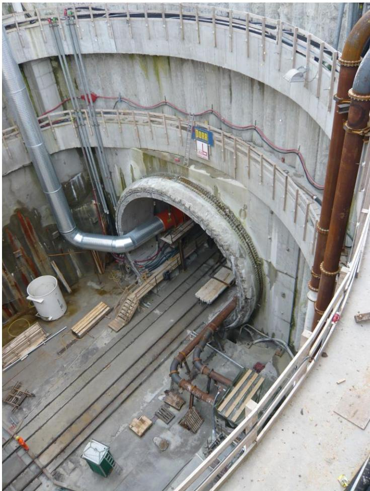
Startbaugrube TBM Durchmesser 13 m, Baugrubentiefe 30 m, Grundwasserspiegel GOK, Umschließung mit überschnittenen Bohrpfählen
